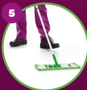
Il est temps de se mettre au travail. Appliquez FUSE sur le sol et étalez-le avec le bandeau mop imprégné dans des conditions comprises entre 18°C et 25°C.
